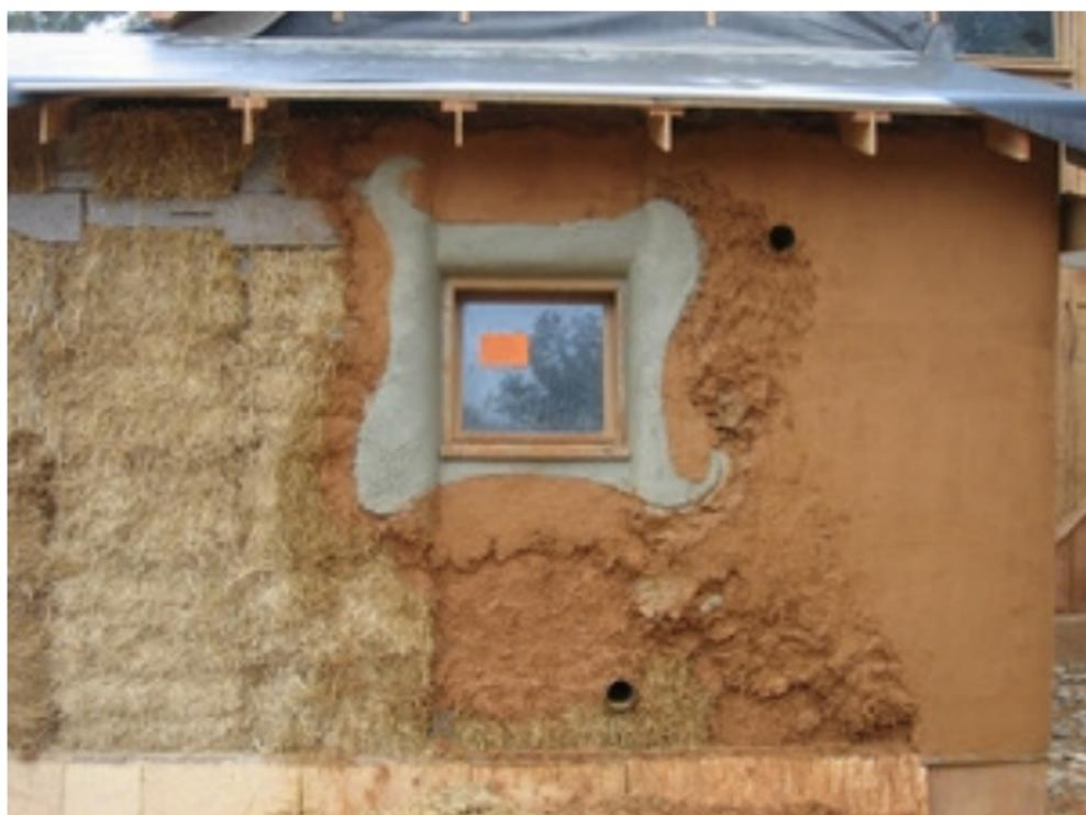
Al contempo l'argilla rappresenta l'anello mancante fra leggerezza e massività, l'alta capacità di assorbimento completa l'assoluta traspirabilità della paglia.
