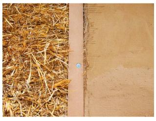
Al contempo la calce e l'argilla rappresentano l'anello mancate fra leggerezza e massività, l'alta capacità di assorbimento di umidità completa l'assoluta traspirabilità della paglia.
